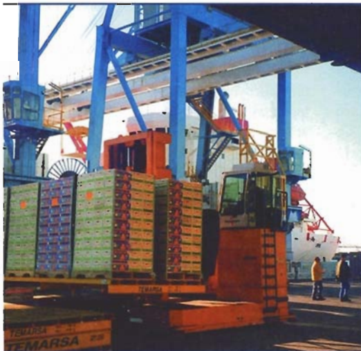
► In Sargunto bei Valencia entstand ein neuer Hafen. Am Hauptkai wurde das hochmoderne Kühlhaus der Temarsa (Terminales Maritimas de Sargunto) mit 20 Kühlzellen (je 48 Paletten à 20 t Kühlgut) errichtet.
